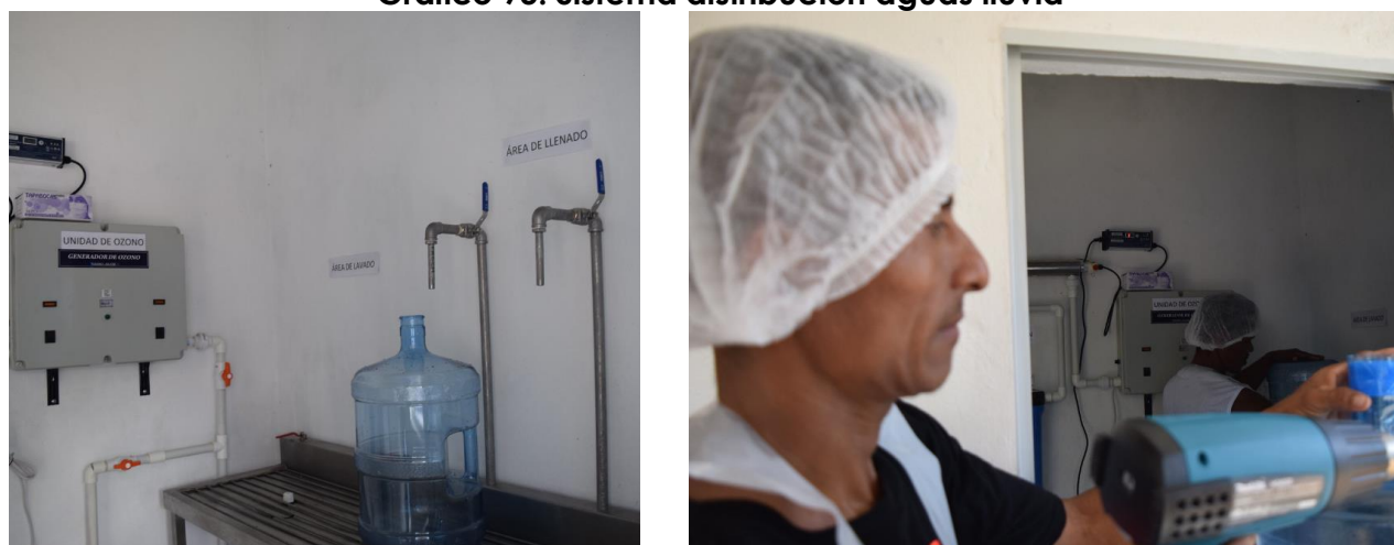
Gráfico 93. Sistema distribución aguas lluvia
