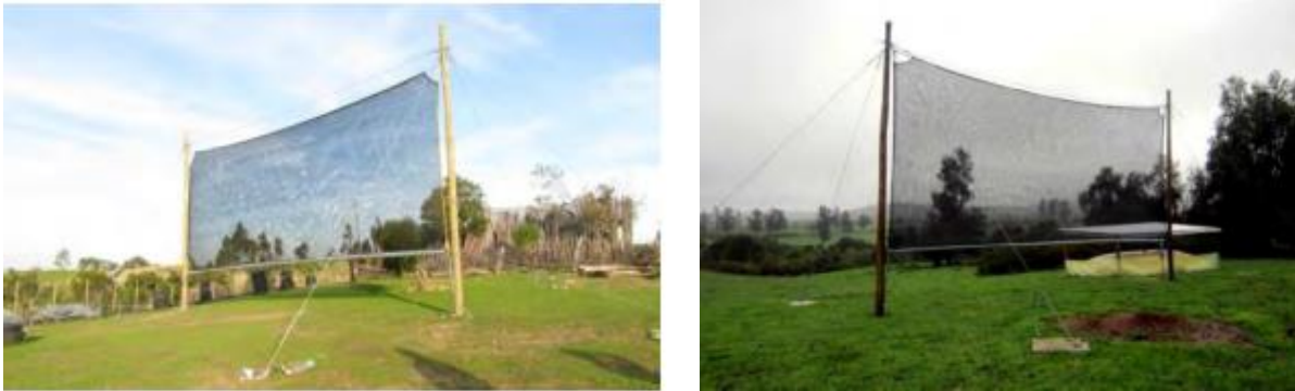
Gráfico 20. Estructura atrapanieblas con malla Raschel – 40 m 2 de superficie – comunas La aguada y Navidad – Región de O’Higgins. Región de O’Higgins.
