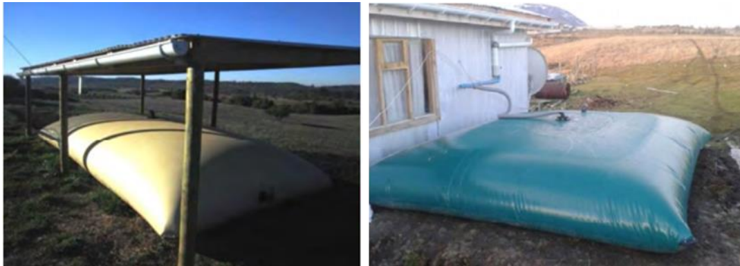
Gráfico 18. Cisterna flexible de 10.000 litros con techo protector - Comuna de Litueche, Región de O`Higgins y Comuna de Natales, Región de Magallanes y la Antártica chilena
