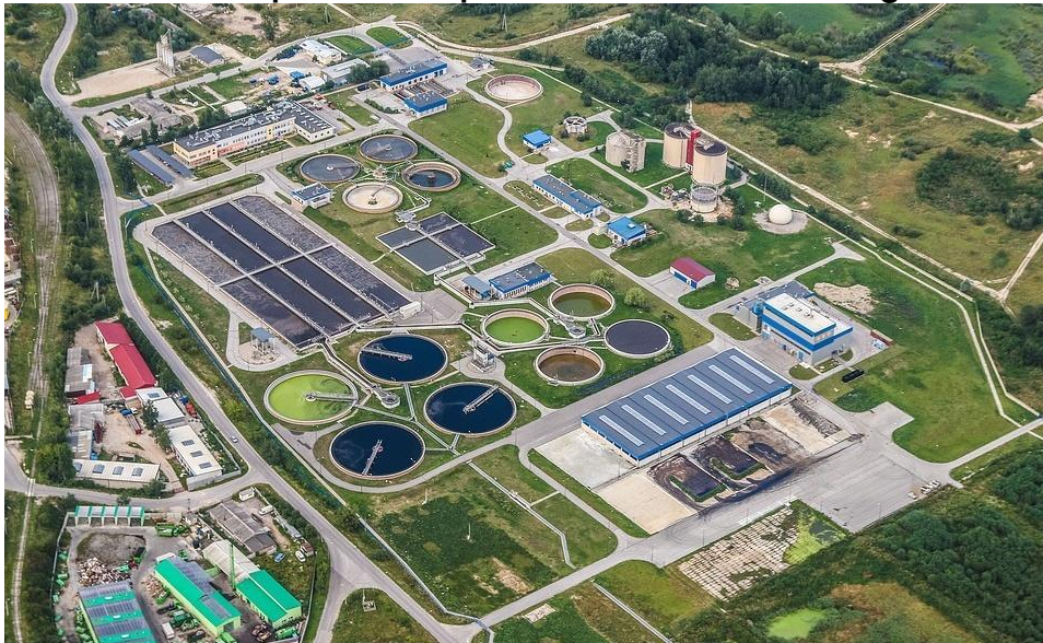
Gráfico 39. Vista superior de la planta de tratamiento de agua residual.
