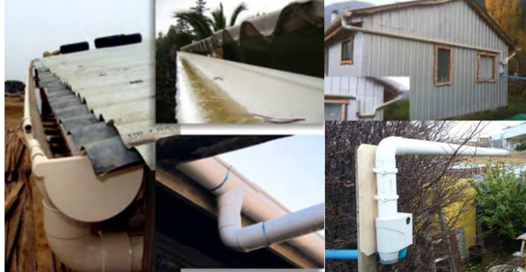
Gráfico 17. Sistema captación en techos, conducción y filtro de polietileno
