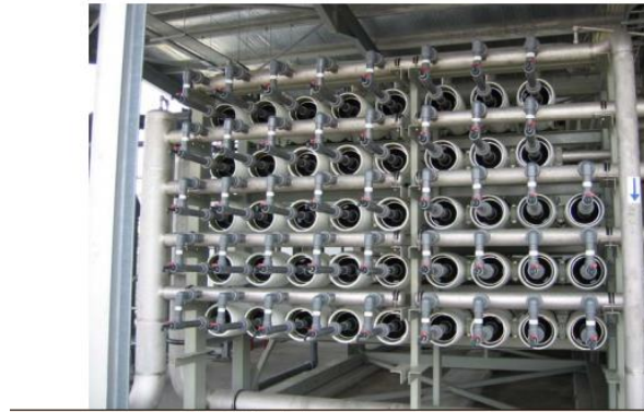
United Envirotech. Módulos de ósmosis inversa
