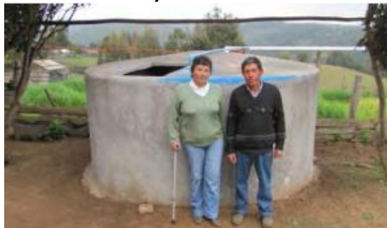
Gráfico 19. Cisternas concreto y ferrocemento - Comuna de Pichilemu.
