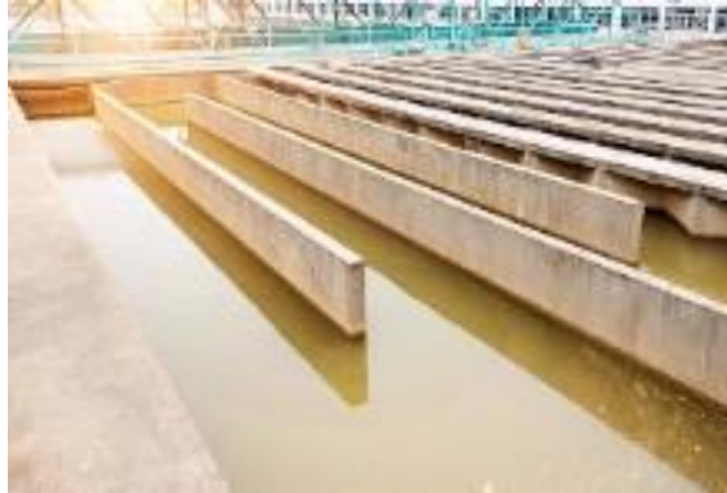
Gráfico 59. Tanque de cloración de aguas residuales
